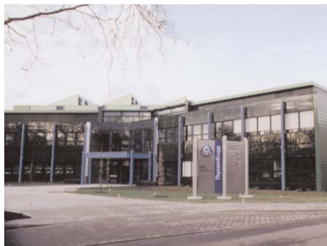
Facility of the Dortmund OberflächenCentrum
